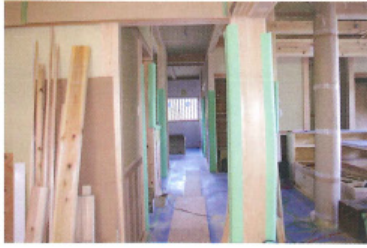
まだ電気の通っていない新築の現場です。
